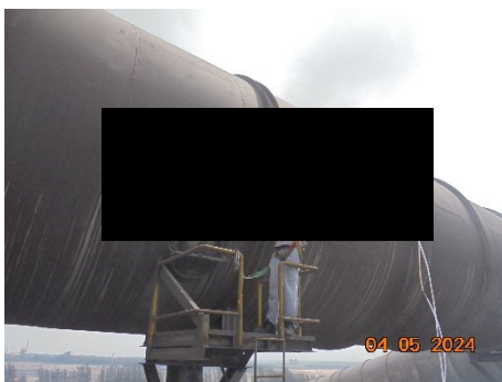
ท่อรวมบนหลังคาโรงหลอมเหล็ก Inlet (EAF)
